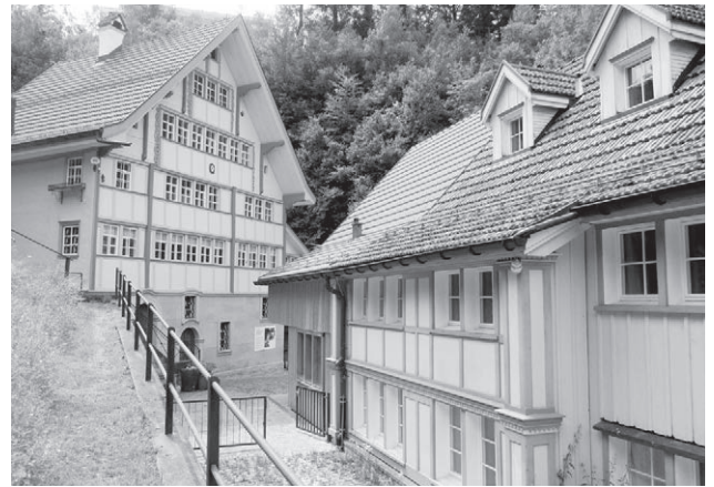
In Bälde wird das eindruckliche Müllereigebäude am Gstaldenbach mit einem Wasserrad und Mühlenraum aufgewertet. Das Nebengebäude dient dem Atelier «Einklang» und den Vorderländer Pfadfindern.
