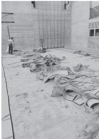
Entfernung des alten Turnhallenbodens
