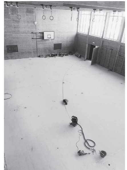
Turnhalle bei Beginn der Trocknungsarbeiten
