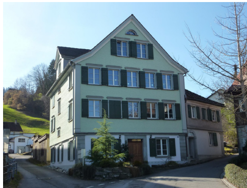
Tobelmühle 357 nach dem Wiederaufbau
