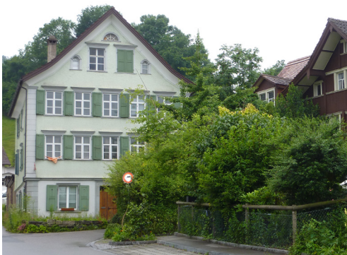
Tobelmühle 357 vor dem Brandfall
