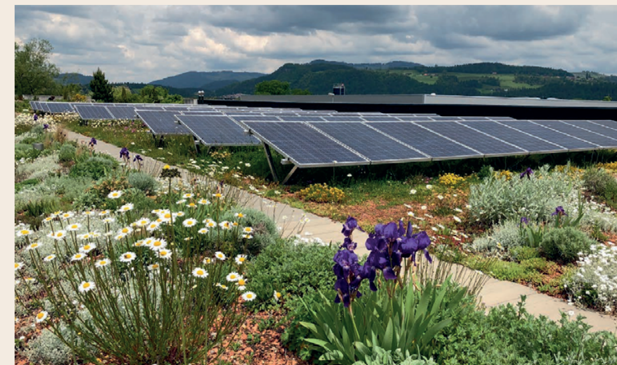
Dachbegrünung und Solarenergieanlage, Contec AG
