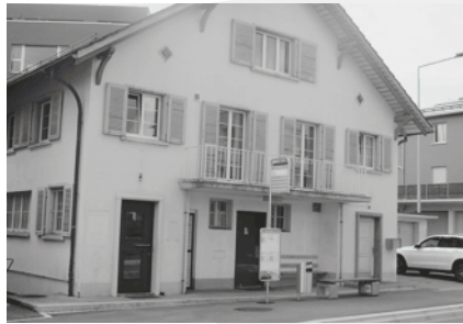
Das ehemalige Posthaus von Wolfhalden ist wieder belebt und dient als reines Wohngebäude.
