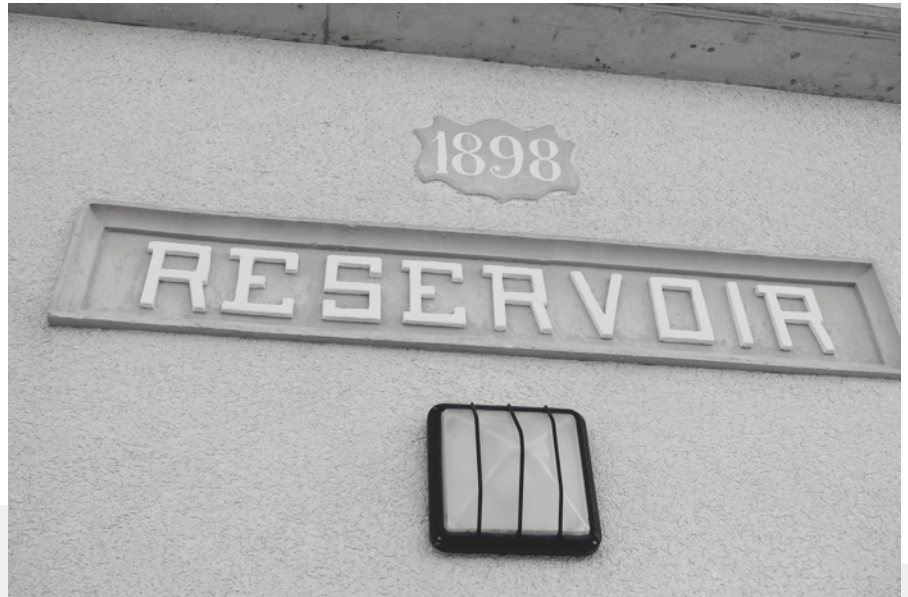
Bereits 1898 war das Reservoir Guggen oberhalb der Strasse Dorf – Hinterergeten fertiggestellt, und die entsprechende Beschriftung zeugt bis heute vom berechtigten Stolz der Vorfahren über das grossartige Werk.
