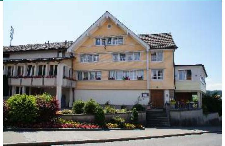
Krone nach der Sanierung 2014
