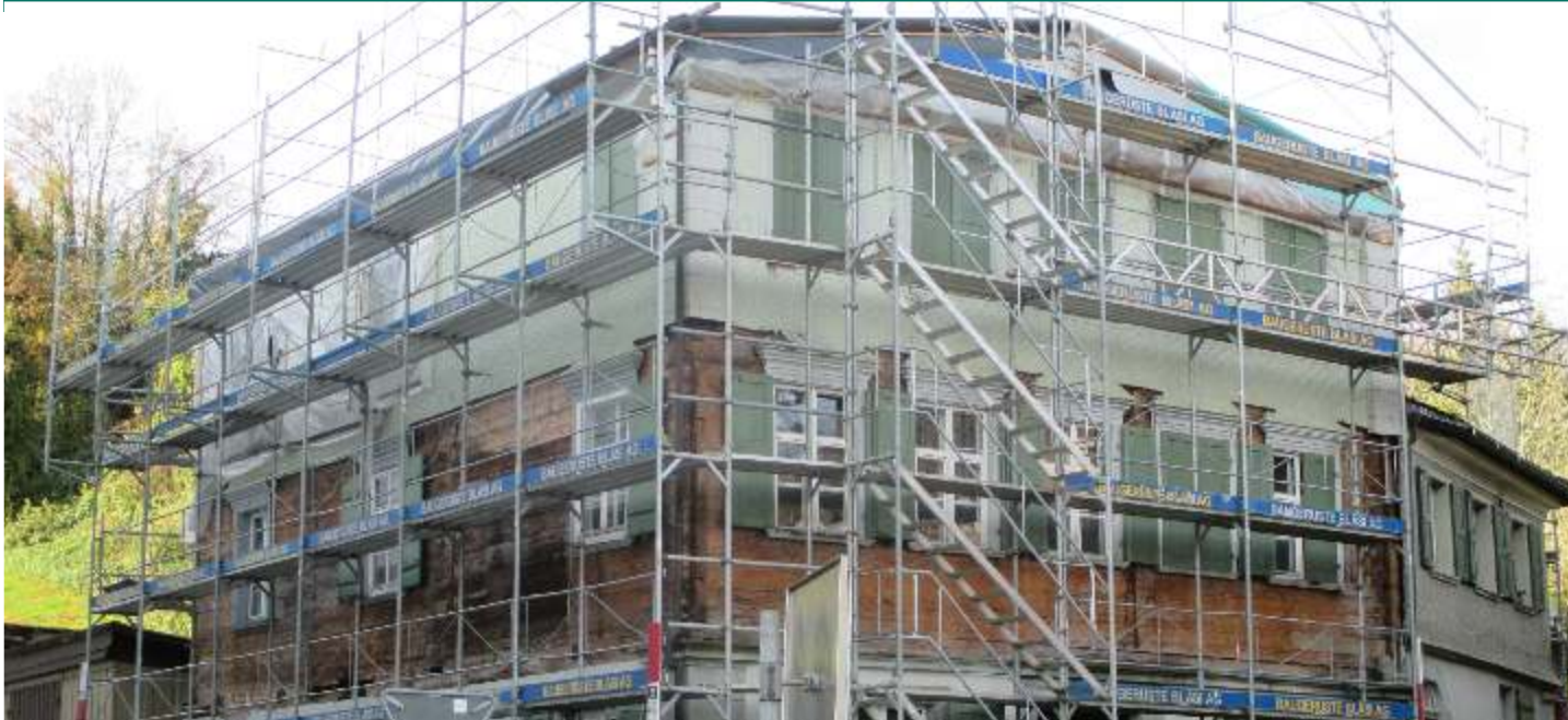
Das durch eine Feuersbrunst beschädigte ehemalige Kaufhaus im Weiler Tobelmühle wird wiederaufgebaut.
