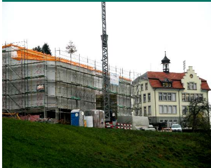
Der erste Teil der Überbauung in der Zelg hat die Richthöhe erreicht und kontrastiert seither als moderner Baukörper mit dem neubarocken Stil des benachbarten Schulhauses.
